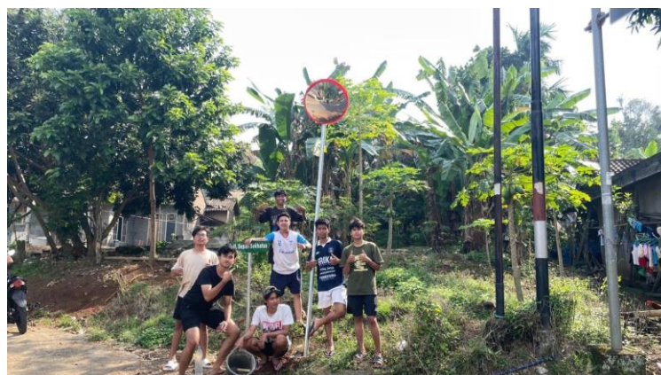
Gambar 25 Pemasangan Cermin Cembung
