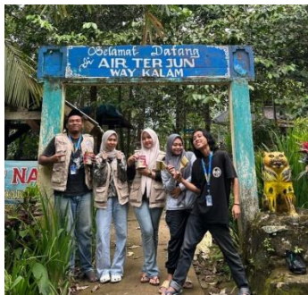
Gambar 29 Pengecatan Gapura Air Terjun Indukan Way Kalam
