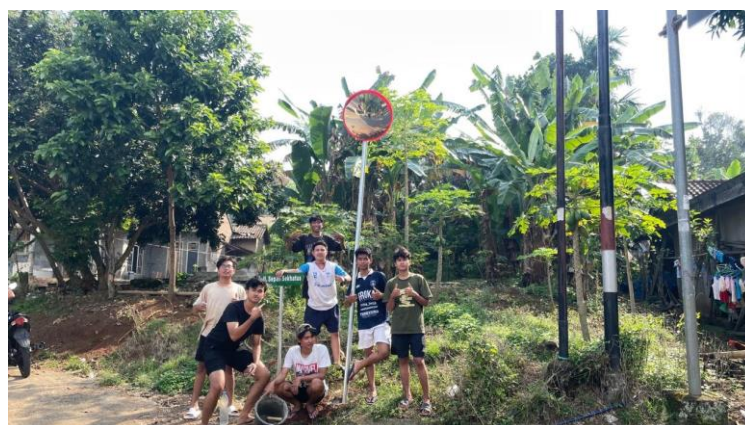
Gambar 24 Pemasangan Cermin Cembung
