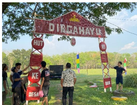
Gambar 13. Proses Pemasangan Gapura
