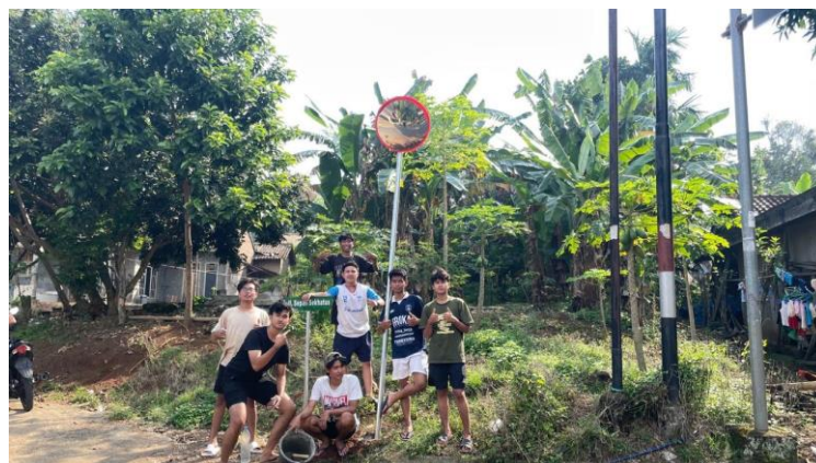
Gambar 24 Pemasangan Cermin Cembung
