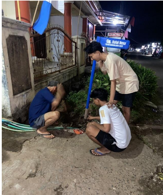
Pemasangan petunjuk jalan
