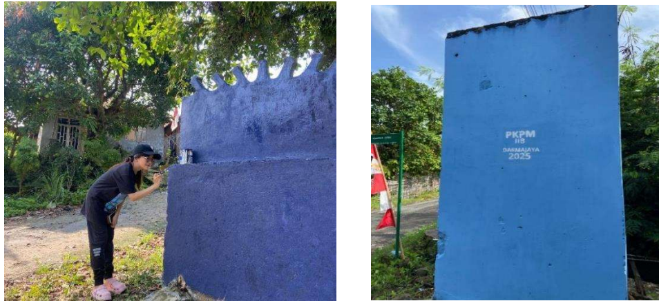
Gambar 2. 13 Pengecatan Gapura Desa Rajabasa
