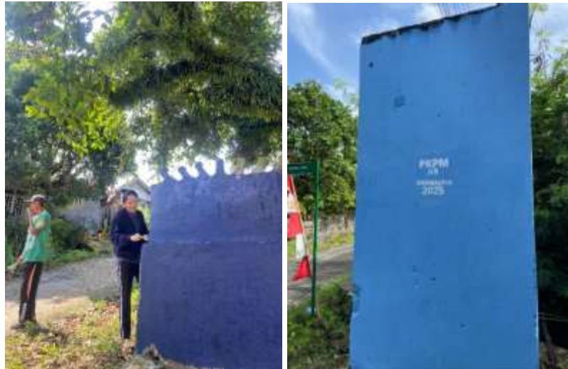
Gambar 2. 16 Pengecatan Gapura Desa Rajabasa
