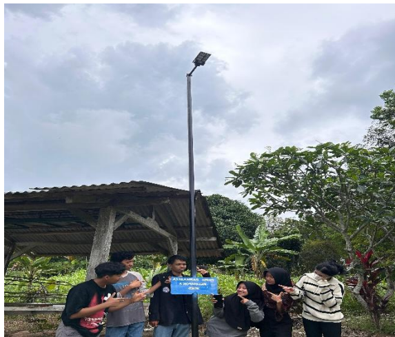
35. Pemasangan Lampu Di Makam
