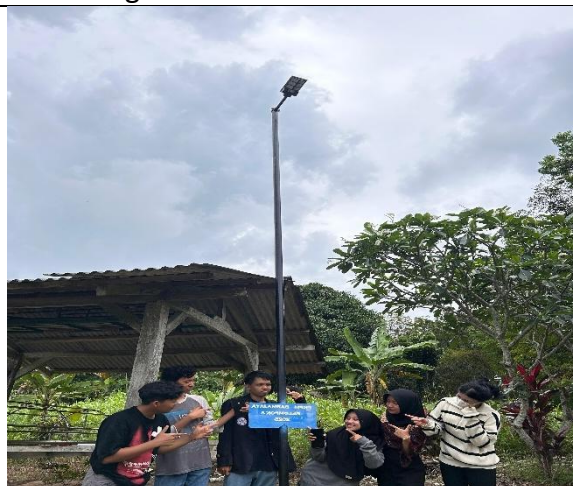
35. Pemasangan Lampu Di Makam
