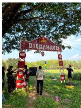
Gambar 6.5 Pemasangan gapura bamboo
