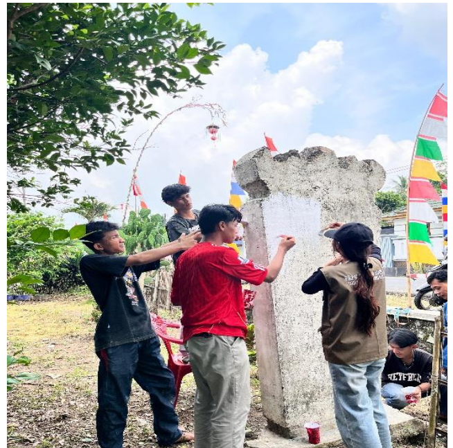
Melakukan pengecatan ulang gapura perbatasan desa ruang tengah di dusun induk
