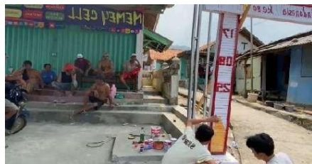
Membantu memasang dan menghias gapura 24
