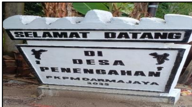
Gambar 25. Perbaikan dan pengecatan ulang gapura Pembatas Desa Penengahan
