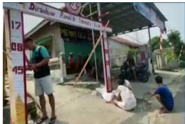
Gambar 37 Membantu pemasangan gapura gang
