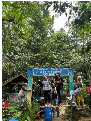
Gambar 11. Pengecatan Ulang Gapura Arter
