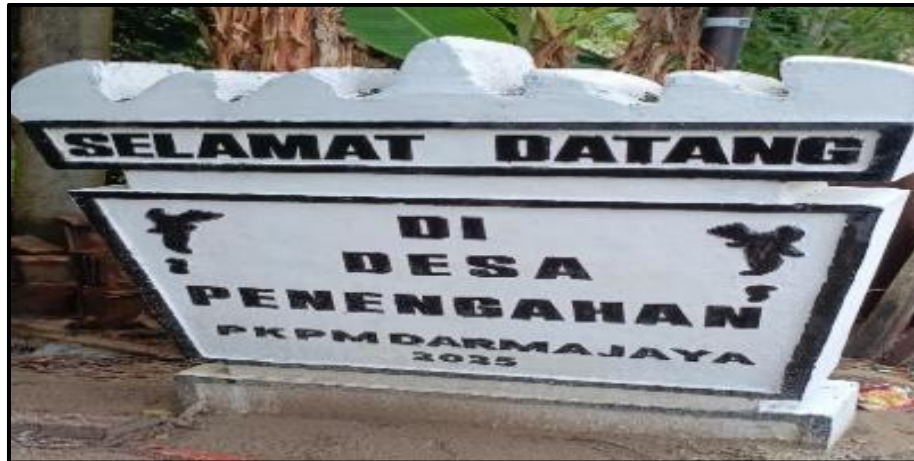
Gambar 13 Perbaikan dan Pengecatan Ulang Gapura Desa Penengahan
