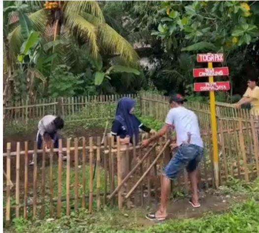
Gambar II-5 Pemasangan Toga PKK
