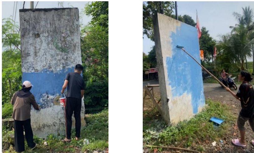
Gambar 2.3.1 Memperbarui cat gapura Desa Rajabasa
