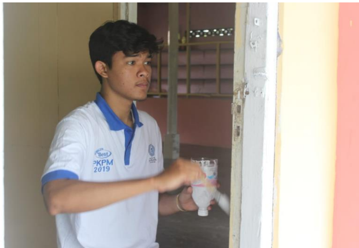
Pengecatan di TPA
