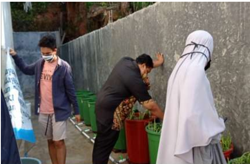
Gambar 3.1 Pembuatan instalasi pembuangan air
