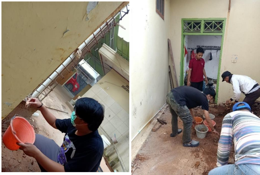
Gambar 4.2 Pembersihan Puing Bangunan Yang Telah Di Bongkar
