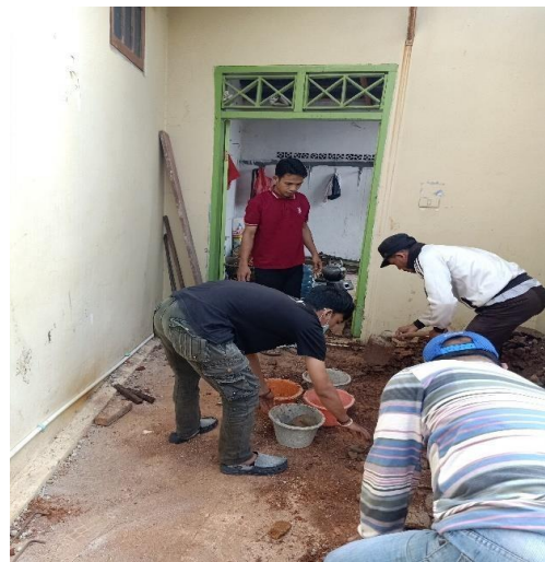
Pembersihan Bongkaran Bangunan
