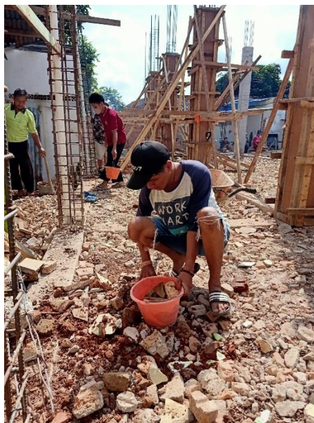
Gambar 2.17 Pembersihan Puing Bangunan Yang Telah Di Bongkar
