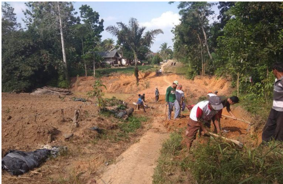
Gambar 3.3 Kerja Bakti Pelebaran Jalan Bendungan Mekar Jaya
