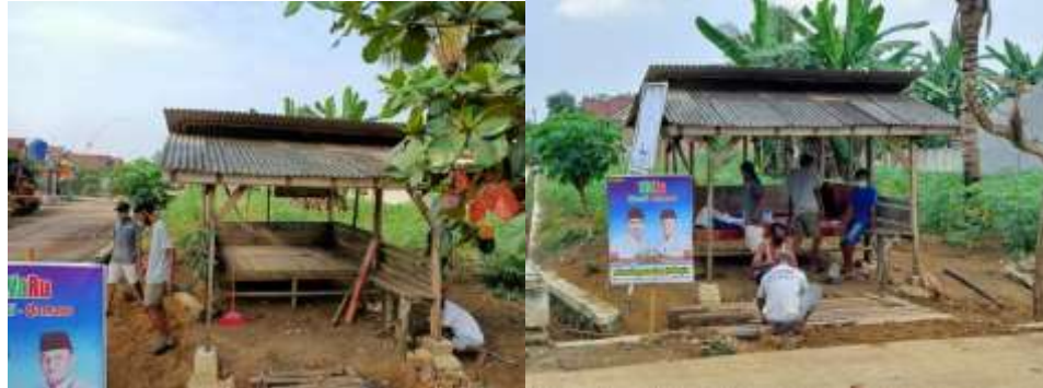
Gambar 2.19 Proses Perbaikan Pos Ronda
