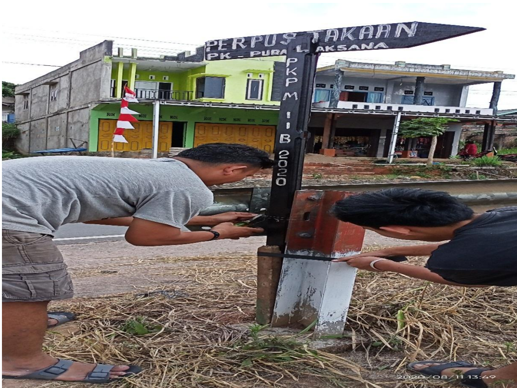
Proses pemasangan papan penunjuk jalan untuk BUMDes Laksana Jaya
