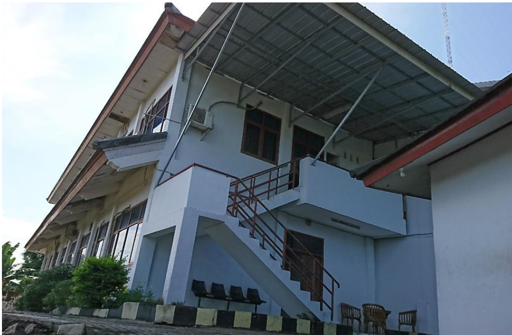
Gambar II.2 Gedung Lampung Post
