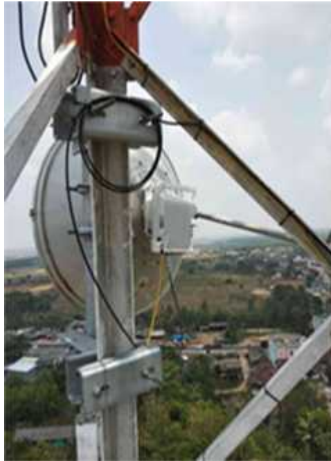
Lampiran Foto Pemasangan Antena Microwafe Tower Informatin
