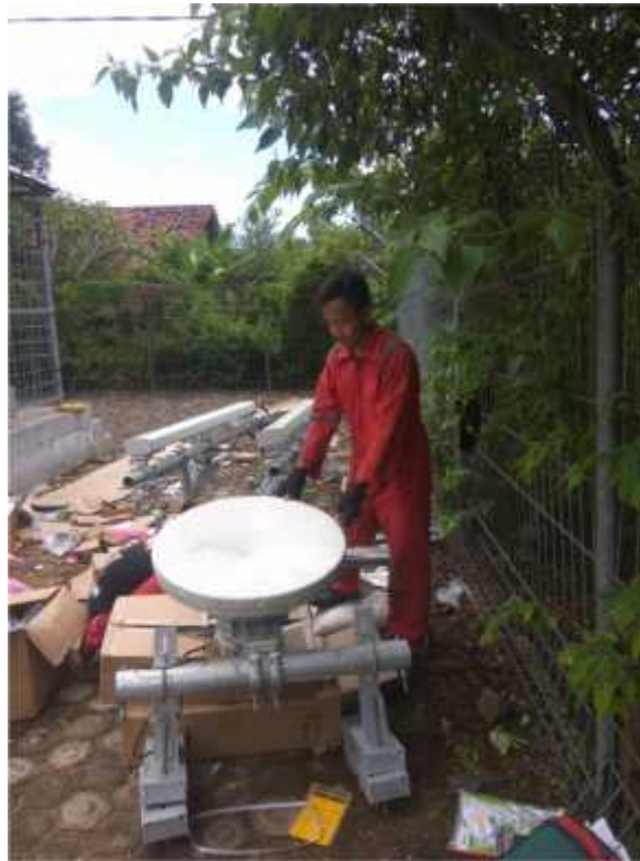
Lampiran Foto Kegiatan Proses Instalasi Perangkat Jaringan
