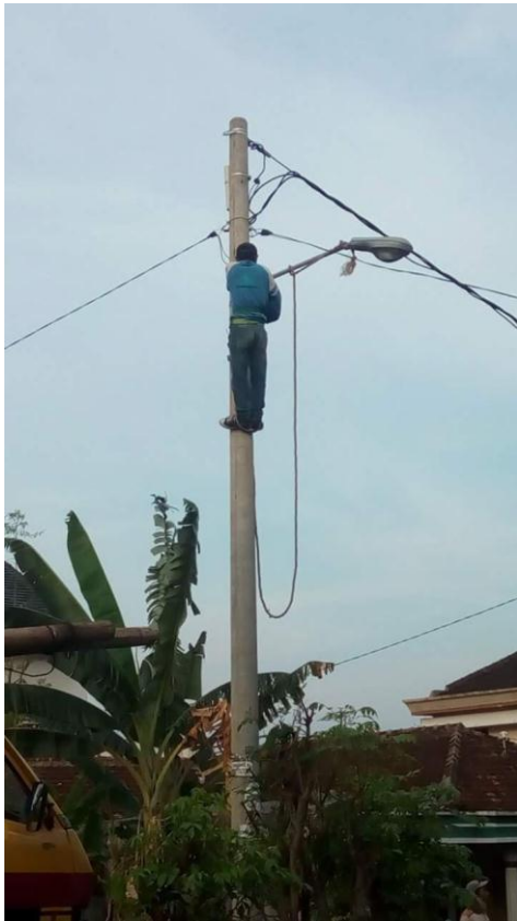
Tidak menggunakan APD
