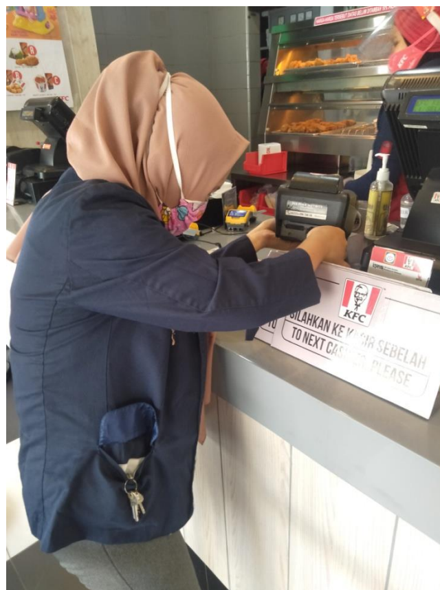
Gambar Lampiran 4 Memperbaiki jaringan kabel utp server offline pada pos kasir
