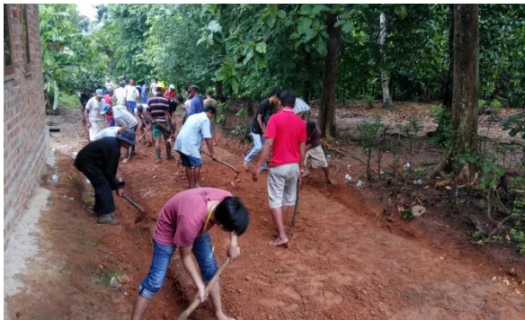
5.3 Gotong Royong Pembuatan Jalan
