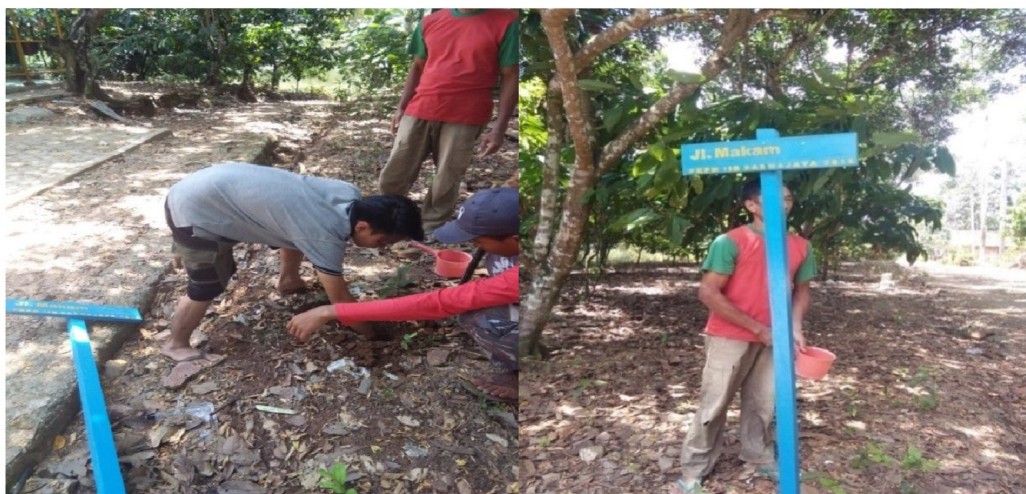
Gambar 28. Pemasangan Plang Nama Jalan
