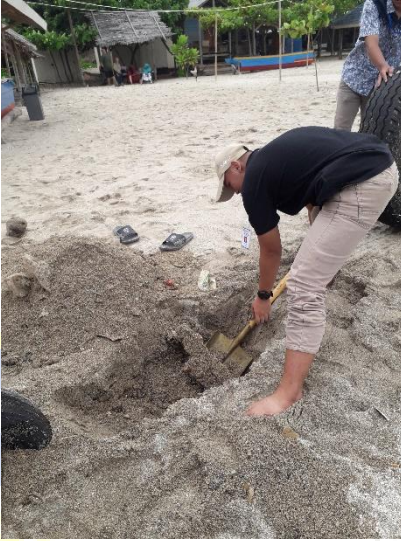
Pembuatan sarana di pantai minangrua
