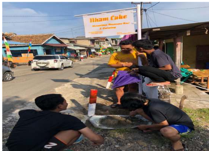
Gambar.5 Pemasangan Plang Usaha UMKM Ilham
