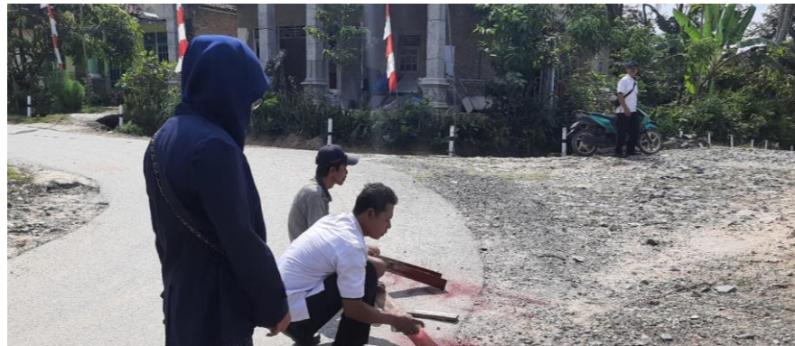
Gambar 2.2 Pengukuran jalan yang ada di Desa Triharjo
