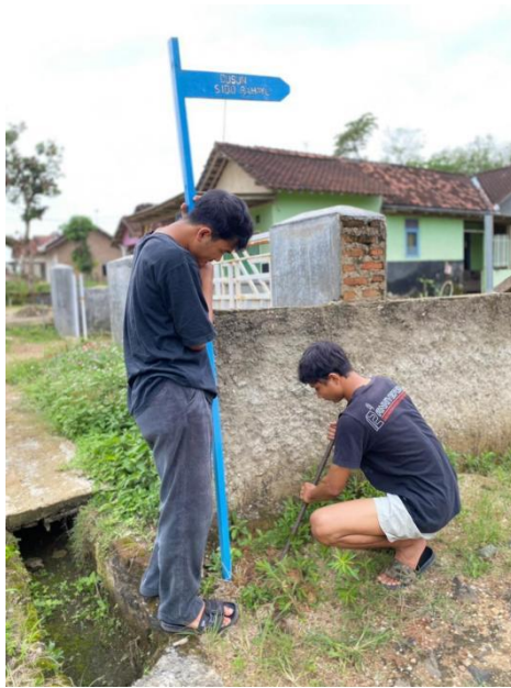
Gambar 13 pemasang plang jalan
