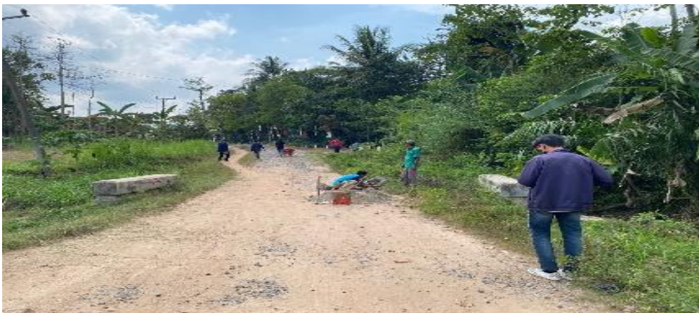
Gotong Royong Perbaikan Jembatan di Dusun Ringin Sari
