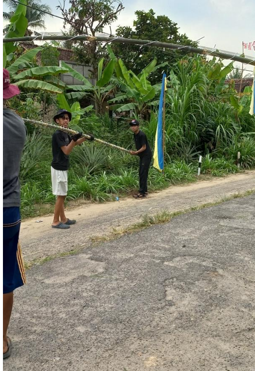
Gambar 7. Pemasangan Lampu Hias
