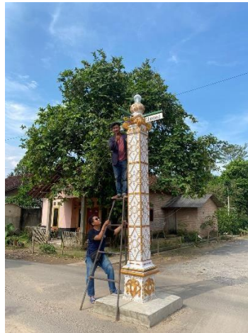
Gambar 7 Pemasangan Plang Jalan untuk kenang kenang an Mahasiswa PKPM kepada Desa Rejomulyo
