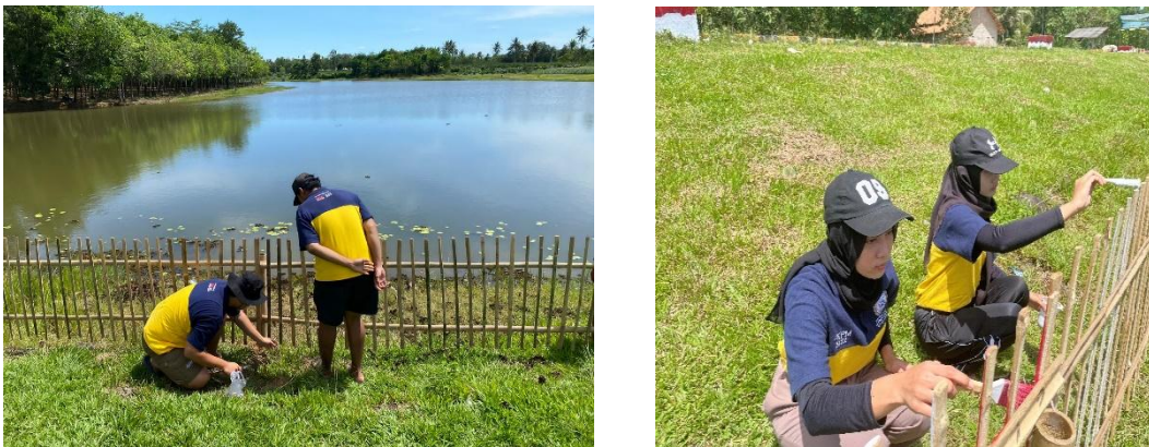
Gambar 2.6 Pemasangan Pager Pembatas Embung Umbul Slawe
