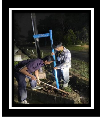
Gambar 2.11 Pemasangan plang jalan
