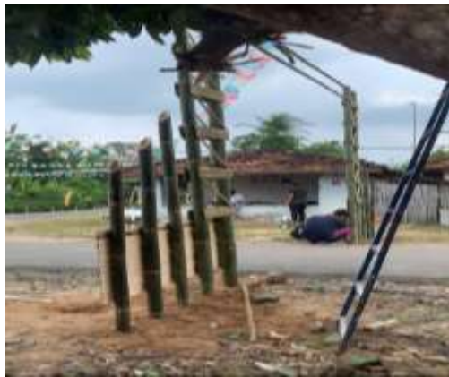
Gambar 18 Memasang dan Mengecat Gapura
