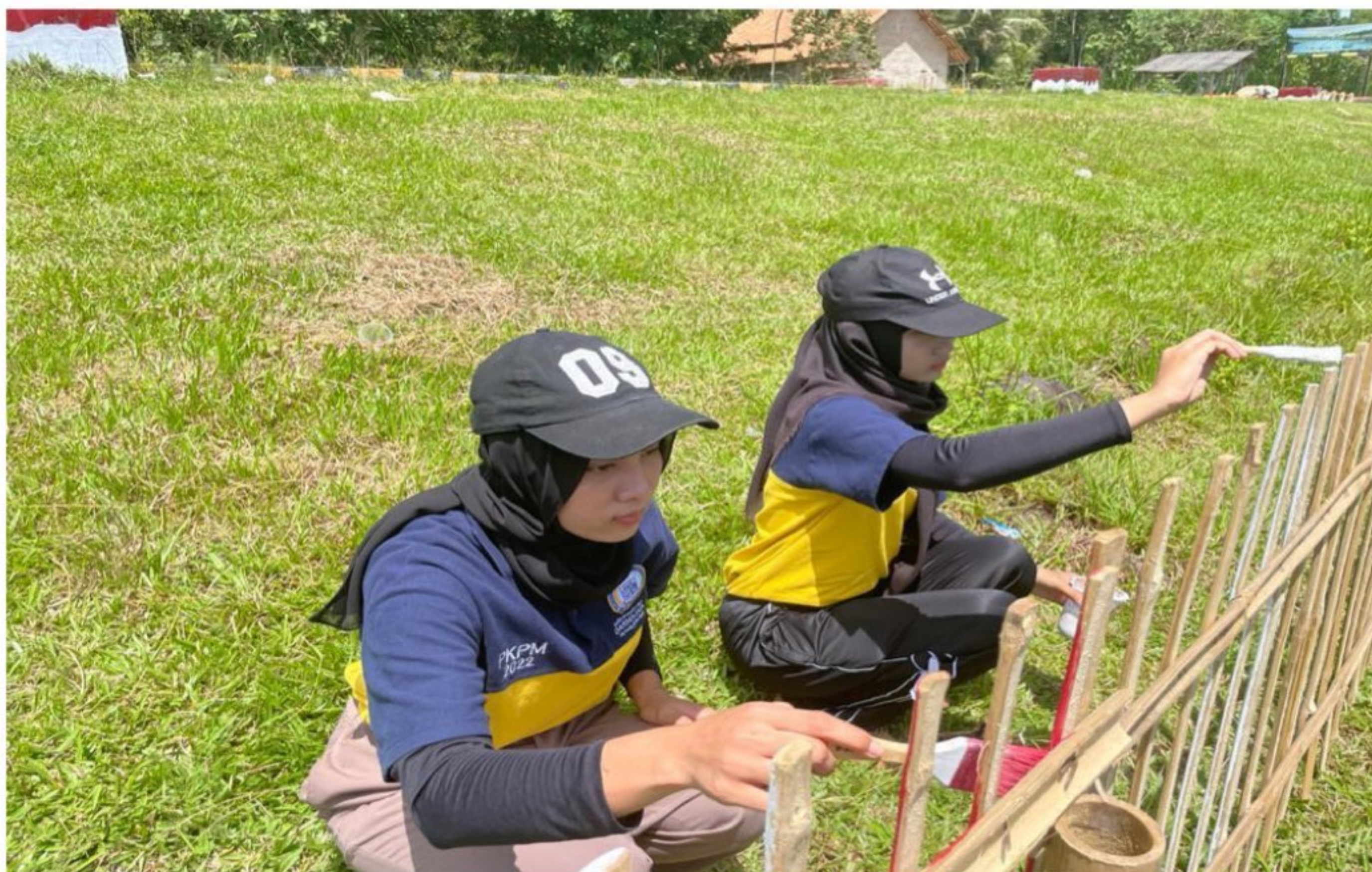
Foto Kegiatan Pembersihan dan Pemasangan Pagar Di Embung Umbul Slawe
