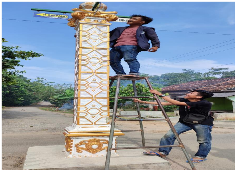
Gambar 2.14 Pemasangan plang jalan desa.
