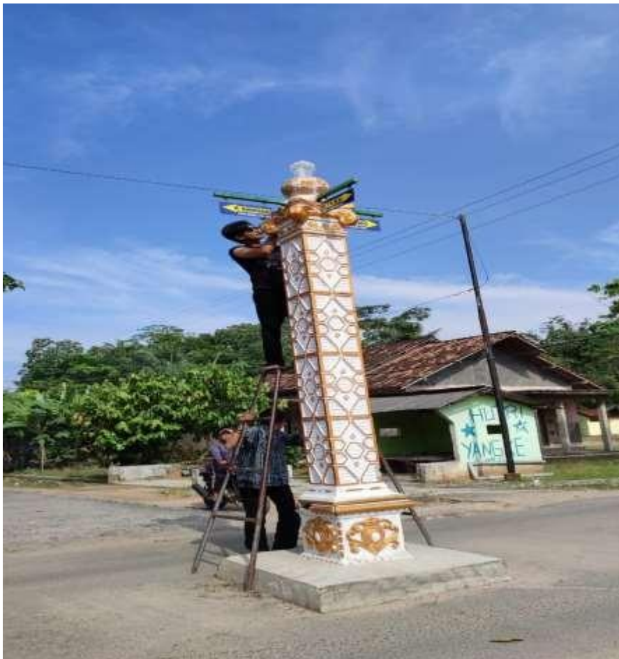
Gambar 3.7 Pemasangan plang arah jalan di Desa Rejomulyo
